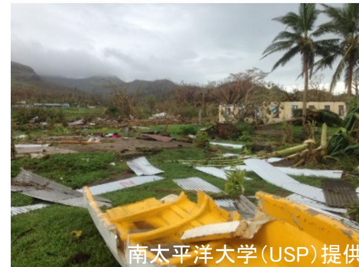
サイクロン・ウINSTON 襲来後の高波被害状況 (2016年2月フィジー)
