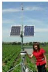
(19) 固定カメラ + ソーラパネル
