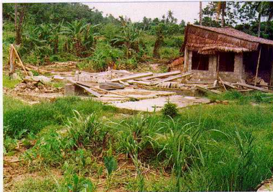
Rumah yang rusak ditenggelam banjir Sungai Suga di samping Jembatan Suga
